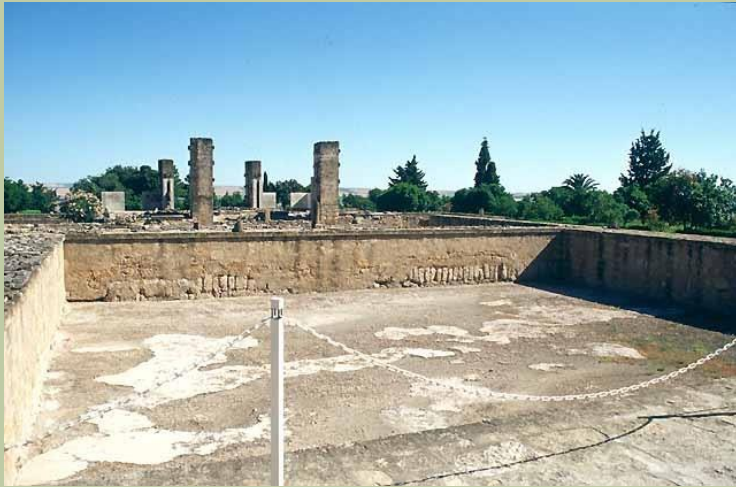
استخر پیش از بازسازی و چهار جرز از خرابه‌های ساختمان مقابل که مشرف بر استخر بوده‌است.
